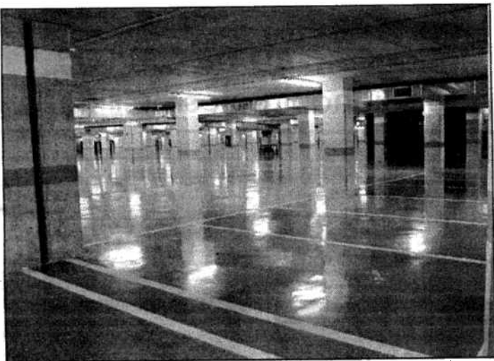
Isla Talleres cuenta con 707 plazas de aparcamientos
