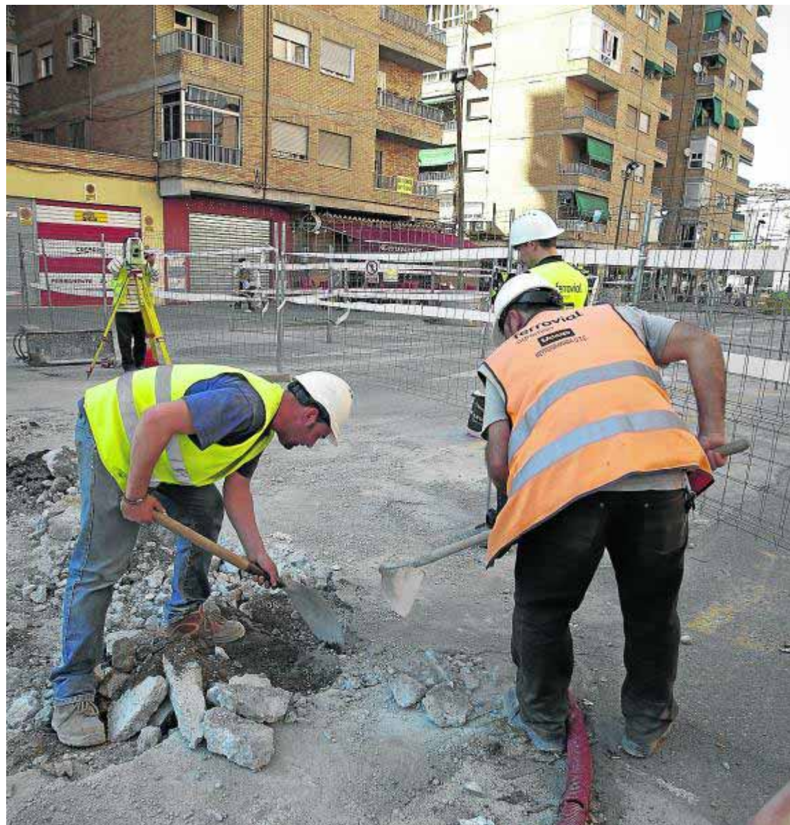
Las obras del metro en el Zaidín ya se han reanudado. ■ ALFREDO AGUILAR
