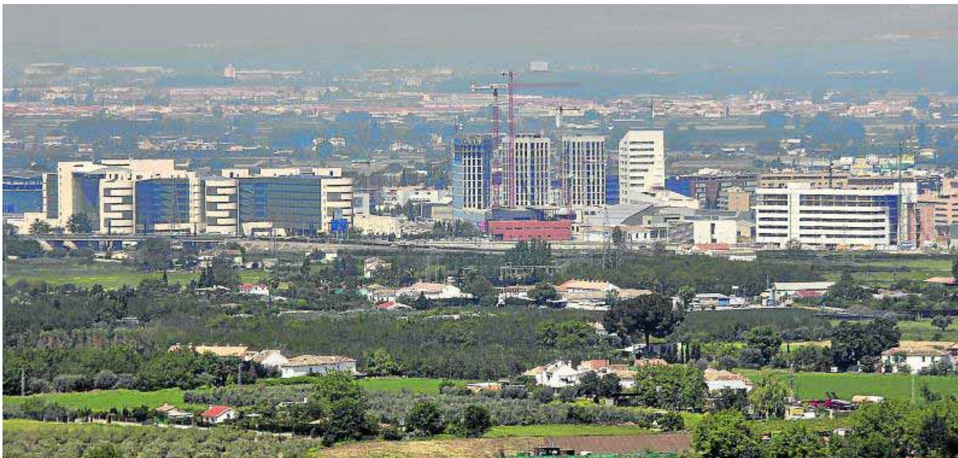
El nuevo hospital, a la izquierda, a la espera de inaugurarse, junto a la nueva Facultad de Medicina, que son los tres edificios altos en construcción a su derecha. :: RAMÓN L. PÉREZ
