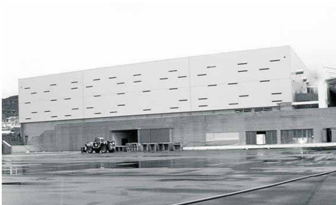
Centro de Tecnificación de Atletismo de Antequera, que podría albergar la pista de hielo. ■ A. FUENTES
