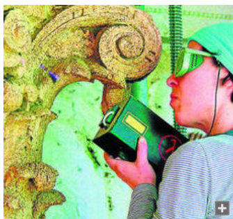
Reparación de una ojiva de la Catedral de Granada.
