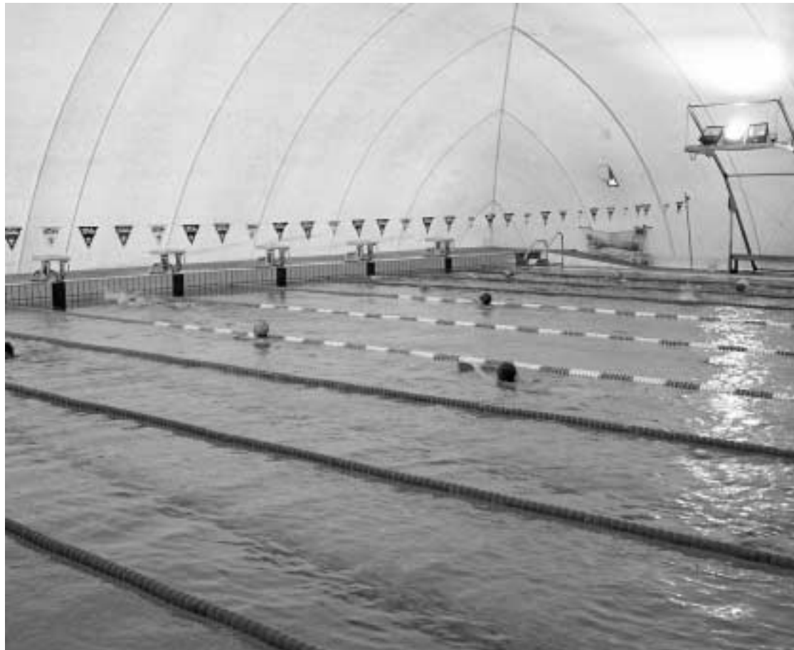
La cubierta de la piscina universitaria de Fuentenueva va a ser renovada el próximo invierno.
