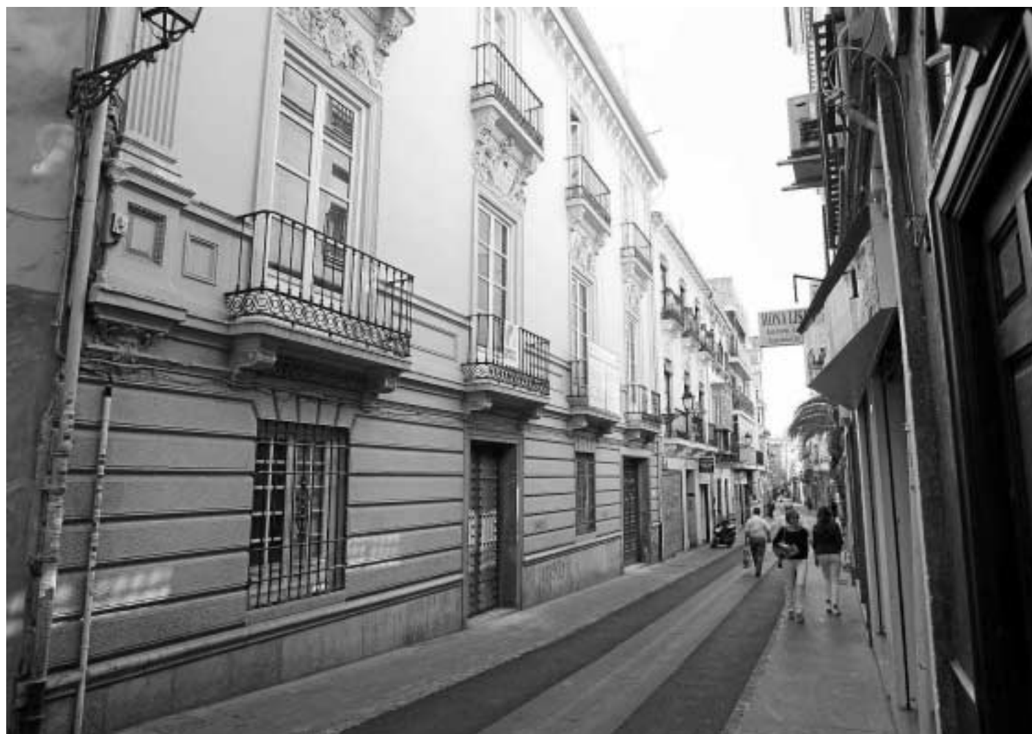
Remodelación del Palacete de los Condes de la Jarosa, que albergará a primeros de 2012 la nueva Escuela de Posgrado de la UGR.
