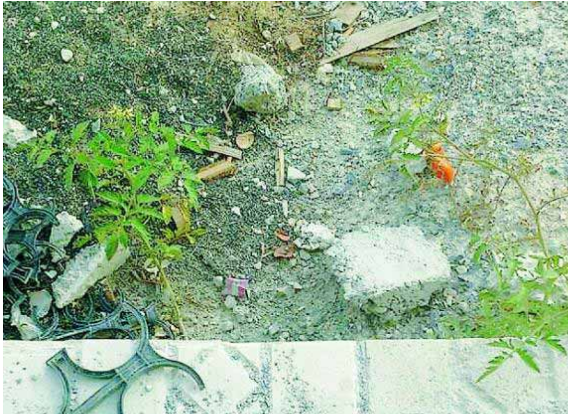
Tomateras en las obras del metro cercanas a la Caleta. :: BARTOLOMÉ BIEDMA.
