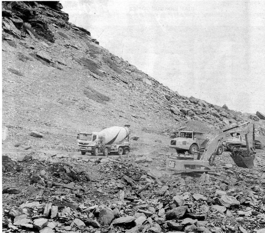
Camiones en las obras de la pantaneta para la Universiada. :: IDEAL
