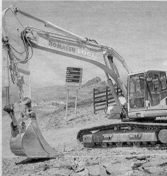
Una de las máquinas que está trabajando en la Sierra.
