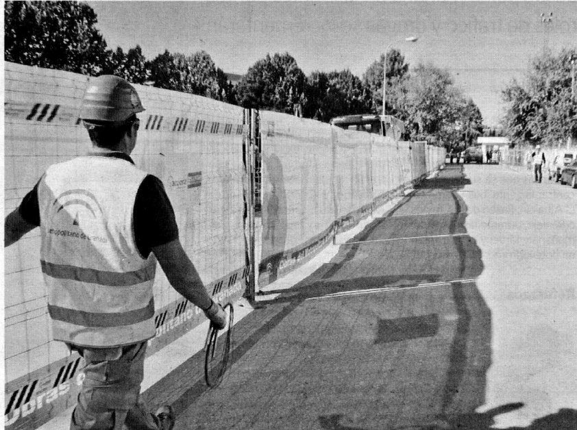
En los Paseillos ya lucen las vallas del Metro.
