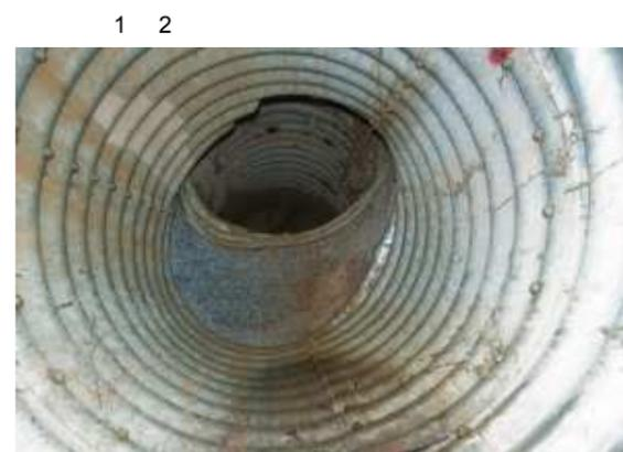
Pozo roto. El empuje de la tierra ha seccionado un pozo de acero con un metro de diámetro y 30 de hondo.: CEDIDA A IDEAL
