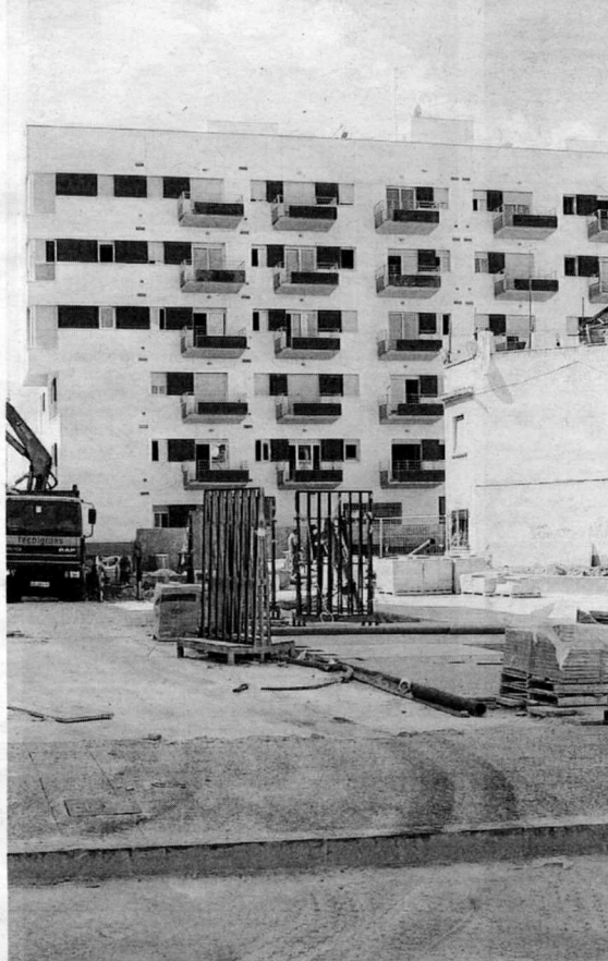
Trabajos en una de las primeras fases de Santa Adela.
