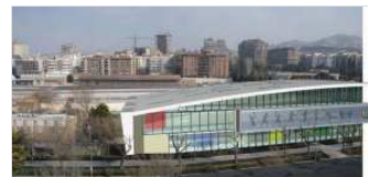
Instalación a construir en el campus universitario de Fuentenueva. / IDEAL
