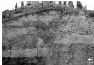
La arista del Tajo de San Pedro coincide con una de las fallas más importantes de la Alhambra.
