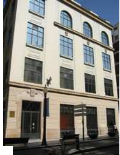
Edificio de Telefónica en Granada. (Gd).
